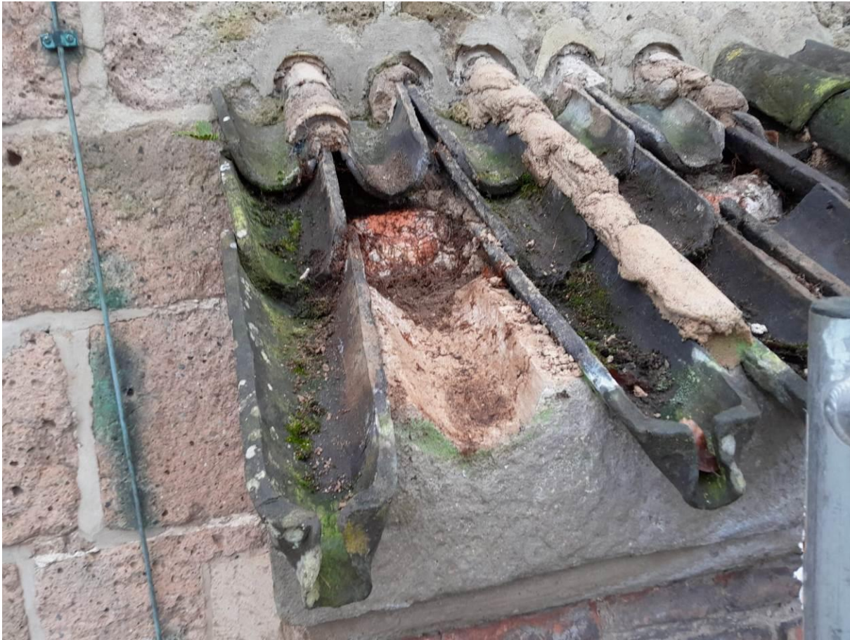
Monniken en nonnen dakbedekking boven de noordelijke entree ligt grotendeels los en wordt opnieuw in de specie gelegd.
