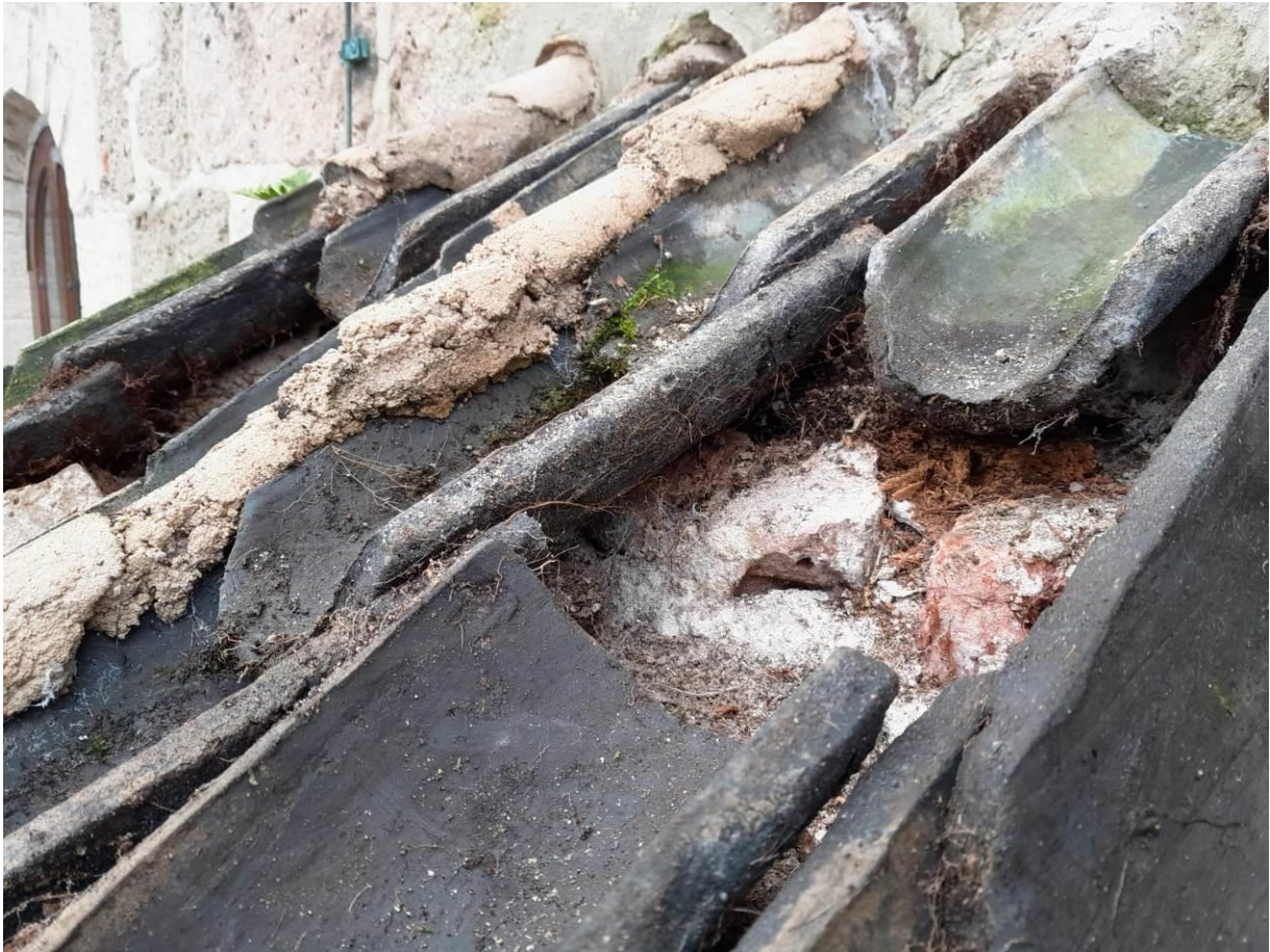
Detailopname van de dakbedekking boven de noordelijke entree.
