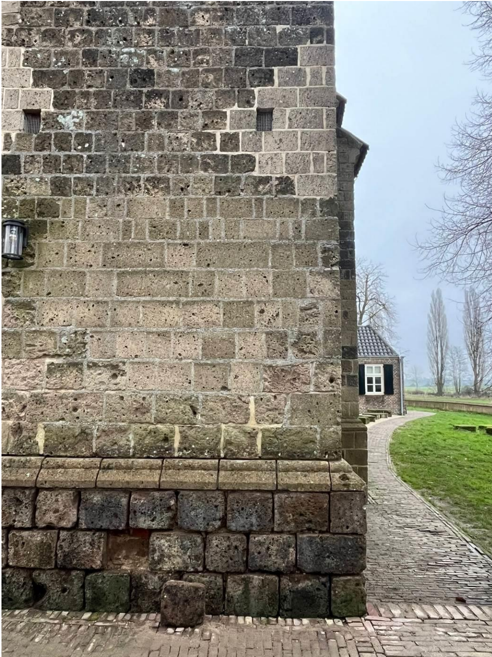
Voegwerk van plint uitgehakt en los tufsteen ingeboet.
