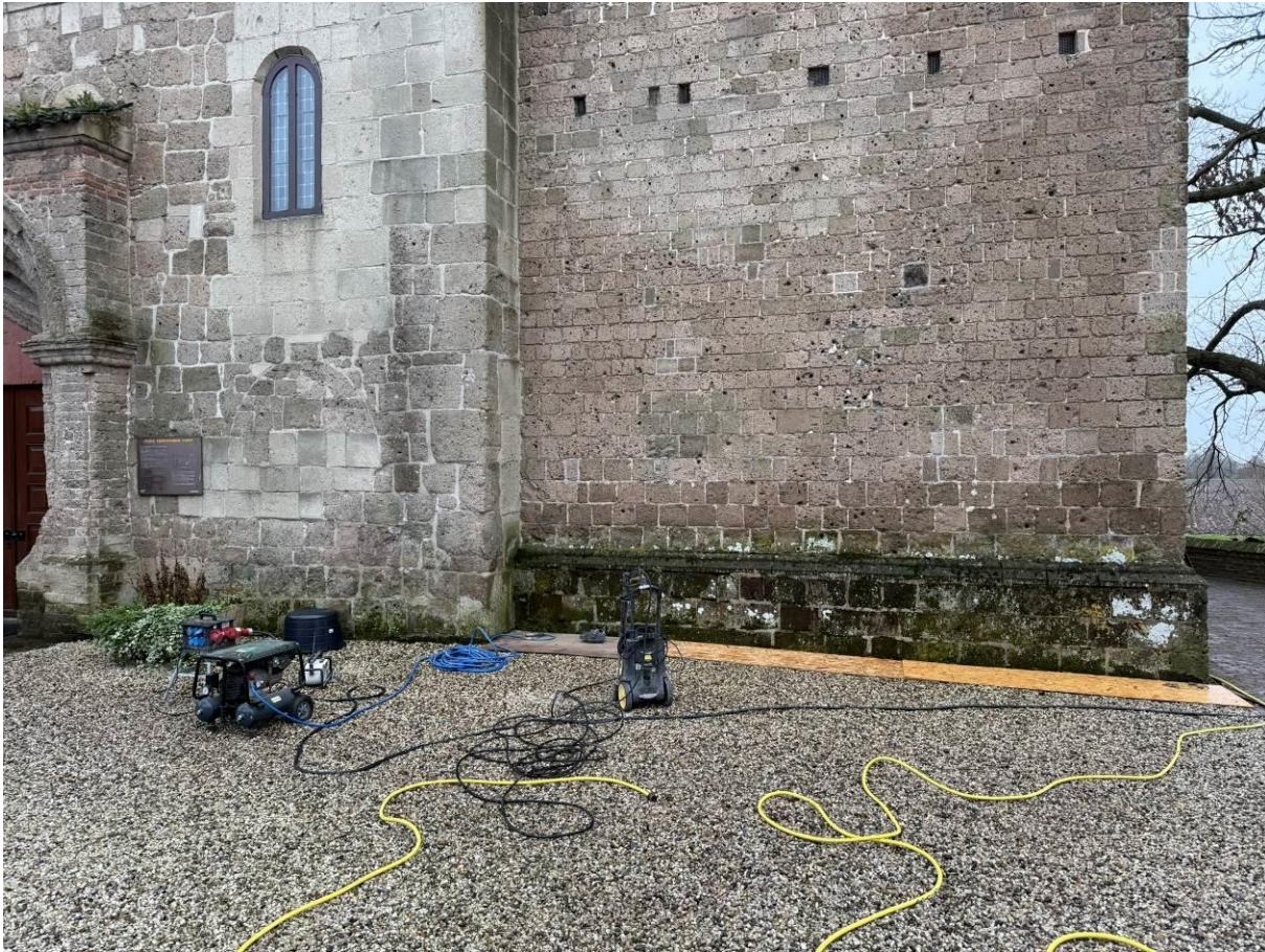
Uitvoering schoonmaken plint t.b.v. voegwerkherstel tufstenen plint.
